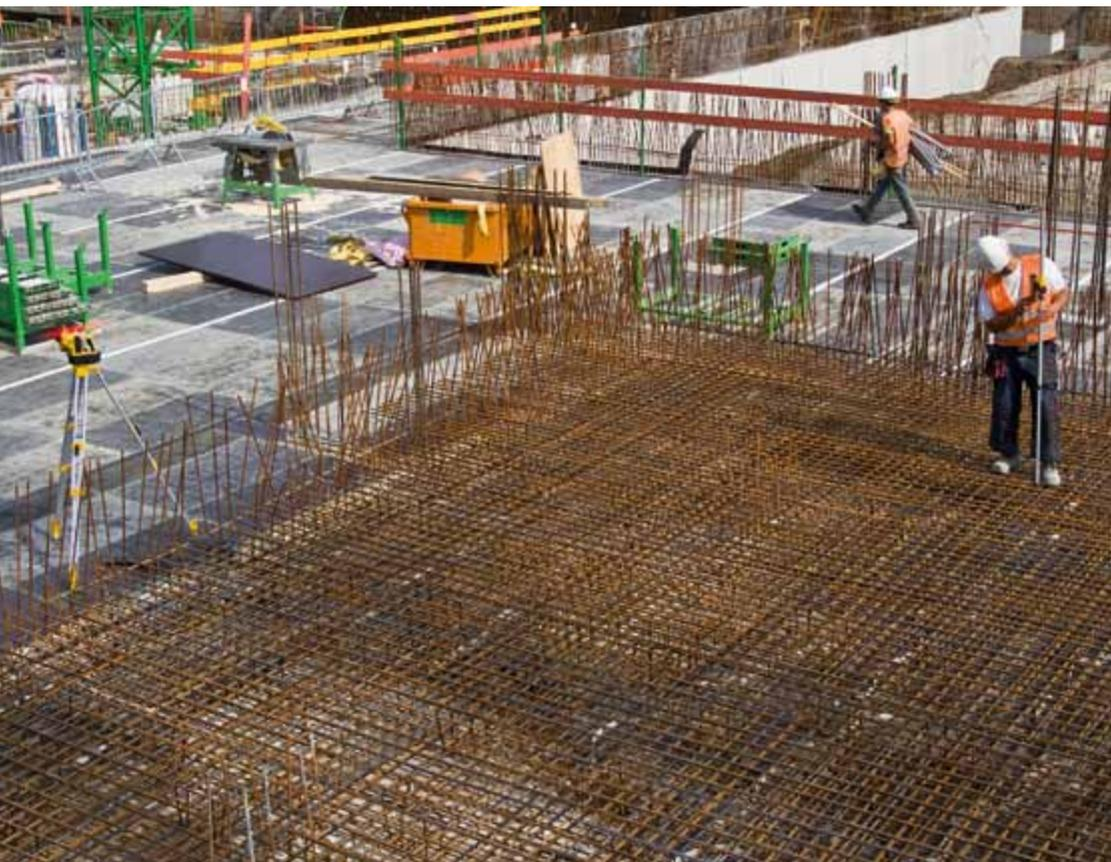
▲ Trabajo más rápido demostrable: con la línea horizontal y el receptor. Tanto en el interior como en el exterior.
