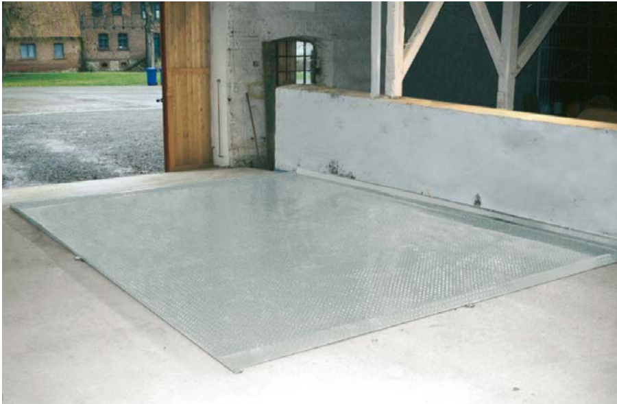
Puesto de repostaje Básico
