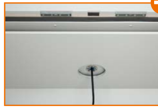
Paso de cables
