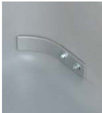
Fijación de la plataforma (refuerzo)
