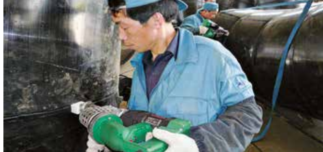
La FUSION 2 en la construcción de recipientes.
