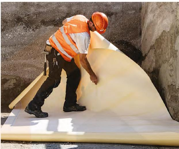
A evolução mais recente das membranas poliméricas são os sistemas avançados com aderência total ao betão estrutural. O material base satisfaz os mais exigentes ensaios de durabilidade, que têm sido utilizados para membranas de impermeabilização poliméricas não-aderidas, no entanto, a ligação ao betão e as sobreposições não são padronizadas, nem extensivamente investigadas quanto à durabilidade.
