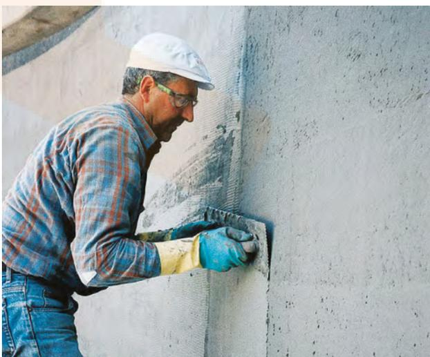
As argamassas aplicadas manualmente ou por projeção proporcionam uma durabilidade razoável em contacto com água potável. Com o aumento do teor de sulfato e magnésio, a durabilidade é reduzida drasticamente.
