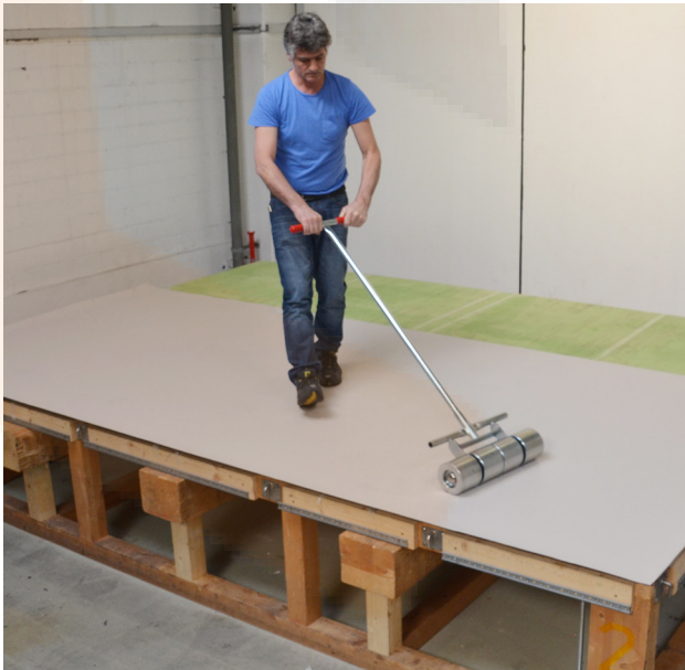
Após disposição da membrana, utilizar um rolo de pesos para pressionar a membrana adequadamente à base.
