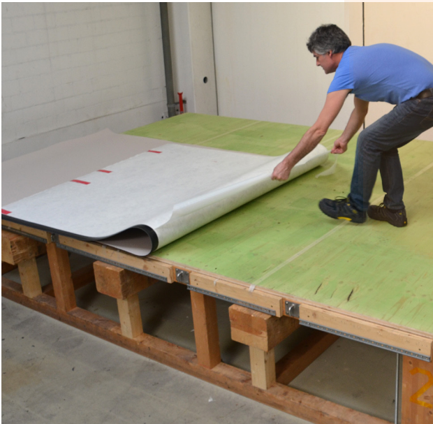
Dobre metade da membrana. Cortar a película de proteção da camada base em toda a largura.
