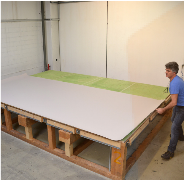
Desenrolar o rolo, alinhado e corretamente posicionado, considerando as sobreposições.
