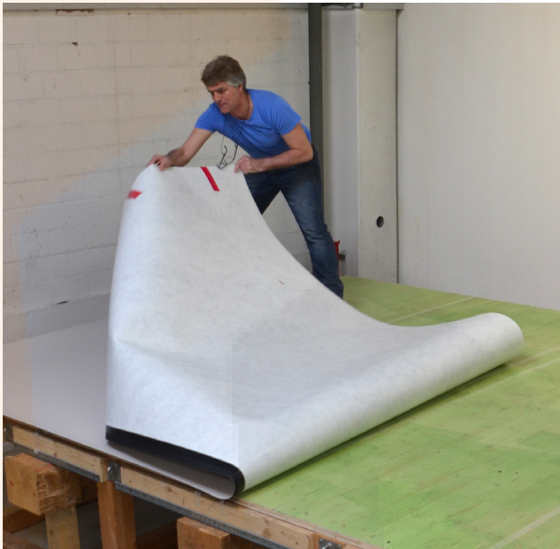
Remover a película de proteção da camada de base, até meio da membrana. Dispor sobre a base. É recomendada a utilização de uma escova ou espátula para evitar bolhas. Repetir o procedimento na outra metade da membrana.
