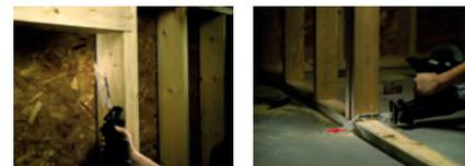
Cortes al ras en el suelo – El protector evita que los dientes se dañen con el contacto del suelo al cortar al ras
