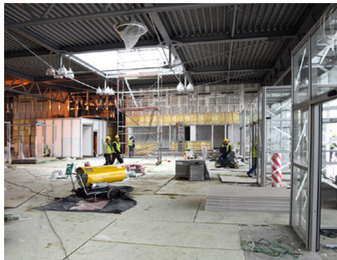
Master B 180 en una obra
