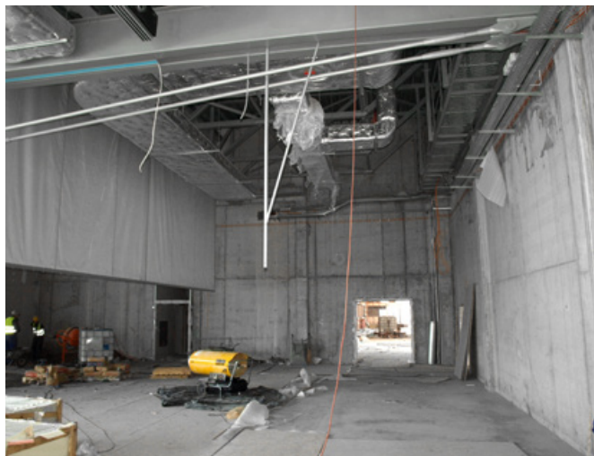
Obras del aeropuerto Master B 360
