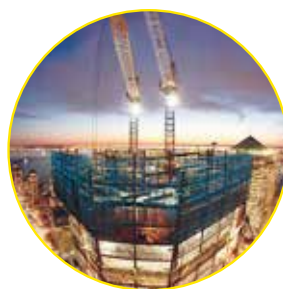
FABRICO DE AÇO ESTRUTURAL
