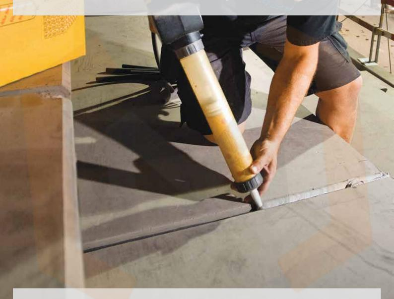
Os selantes de juntas ad<mark>equados a</mark>judam a proteger o meio ambiente contra a contaminação, especialmente os lençóis freáticos, em áreas destinadas ao armazenamento e manuseamento de produtos quimicamente agressivos e líquidos poluentes, tais como postos de abastecimento, baciais de retenção e tanques de armazenagem.
