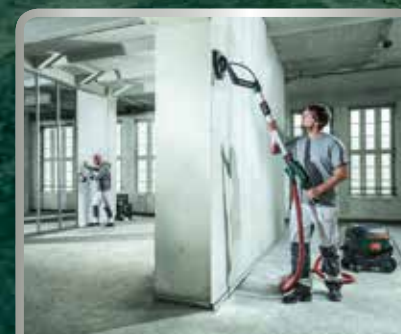
Construcción en seco
