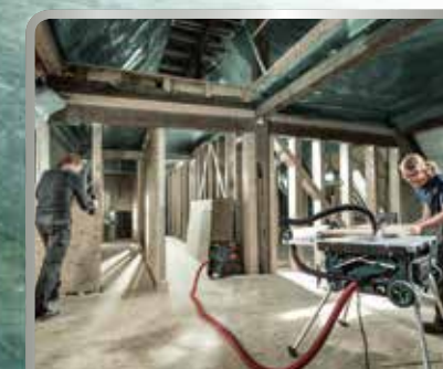
Construcción de techos y madera
