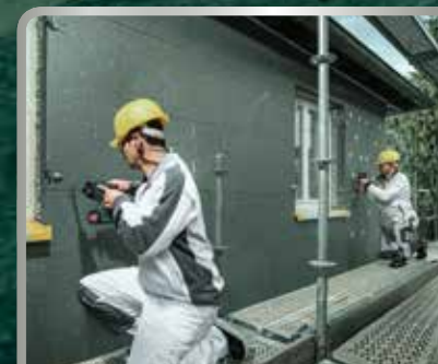
Pared, fachada, ventanas
