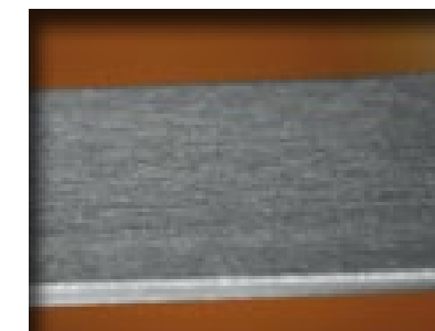
Aspecto de la superficie, tras ser eliminada la capa basta de material por completo.
