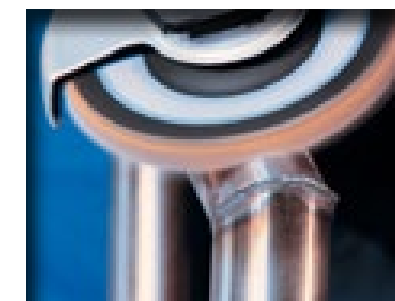
Seleccione el nivel de revoluciones 3* y rectifique el cordón de soldadura fino del pasamanos. Las superficies colindantes no serán dañadas.
