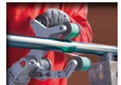
Eliminación del cordón de soldadura.
