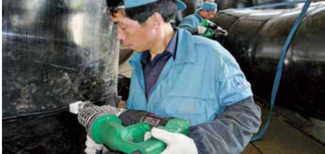
La FUSION 2 en la construcción de recipientes.
