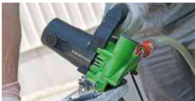
Corte de granito a inglete
