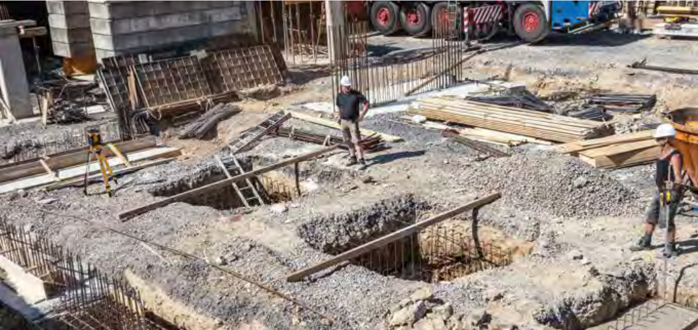
El láser conviene por su fácil manejo y, en combinación con el receptor REC 300 Digital, permite trabajar con rapidez y fiabilidad en un alcance de hasta 800 m.
